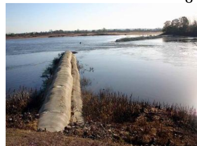
Les seuils expérimentaux du Fresne en 2005 resserrant le passage du courant
