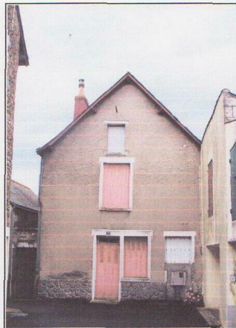
Photos de la façade actuelle du bâtiment #15 rue Sansonnet
