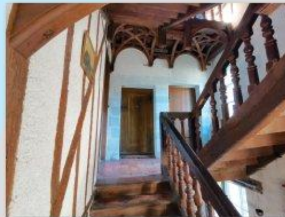
Vue de l'escalier XVII e de l'auberge du Pigeon
