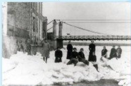
Embâcle en aval du pont, début XX e siècle
