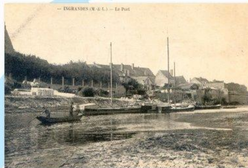
Cale des Pieux, côté Ingrandes
