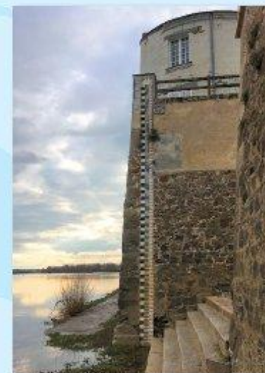
Échelle de crue n°1
