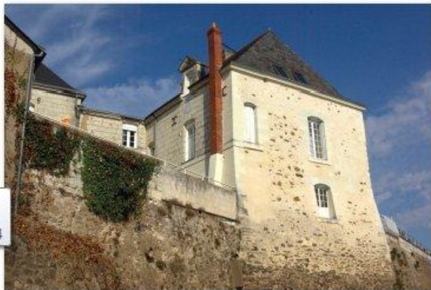
La maison vue depuis la Loire
