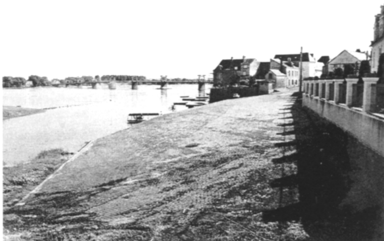
Cale des recroits : rejointoiements, reprise du perré, nettoyage du marécage ....
