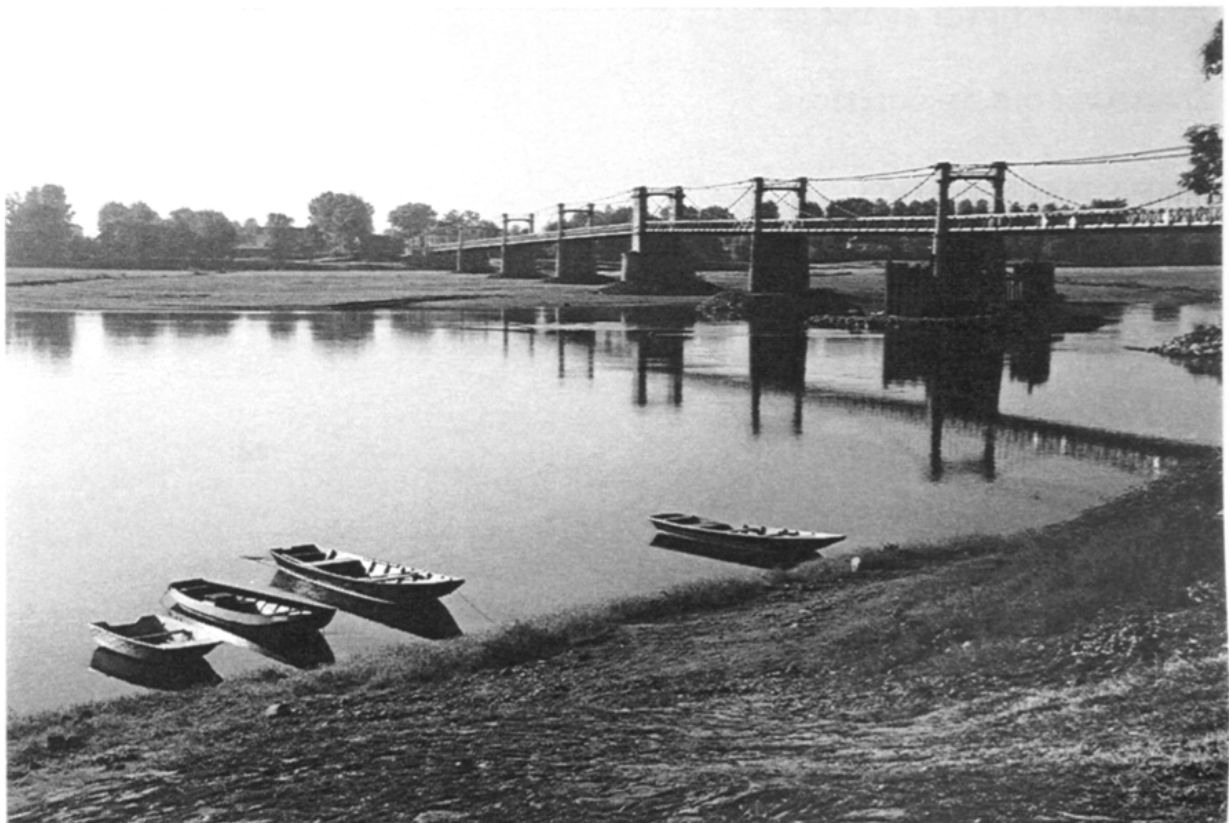
et notre pont, même renforcé est resté inchangé, seules les lavandières nous ont abandonné....
